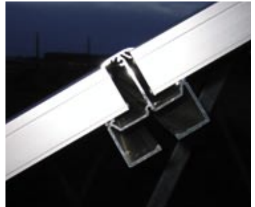
Module werden an kurzen Seiten in Doppelprofile eingesetzt
