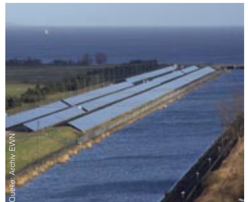
Modultische entlang des Einlaufkanals
