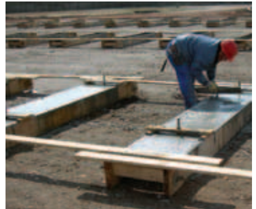
Abziehen der Betonfundamente
