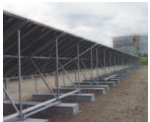
Stahlunterkonstruktion für die Module
