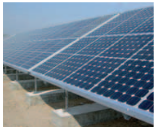
Fertige Modulreihe nach Ausrichtung mit Lasermesstechnik
